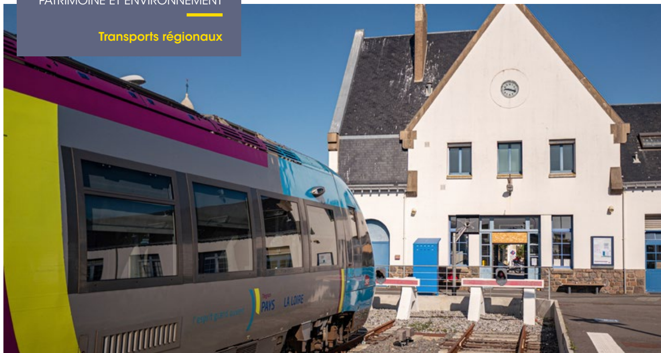
Gare de Saint-Gilles-Croix-de-Vie.
