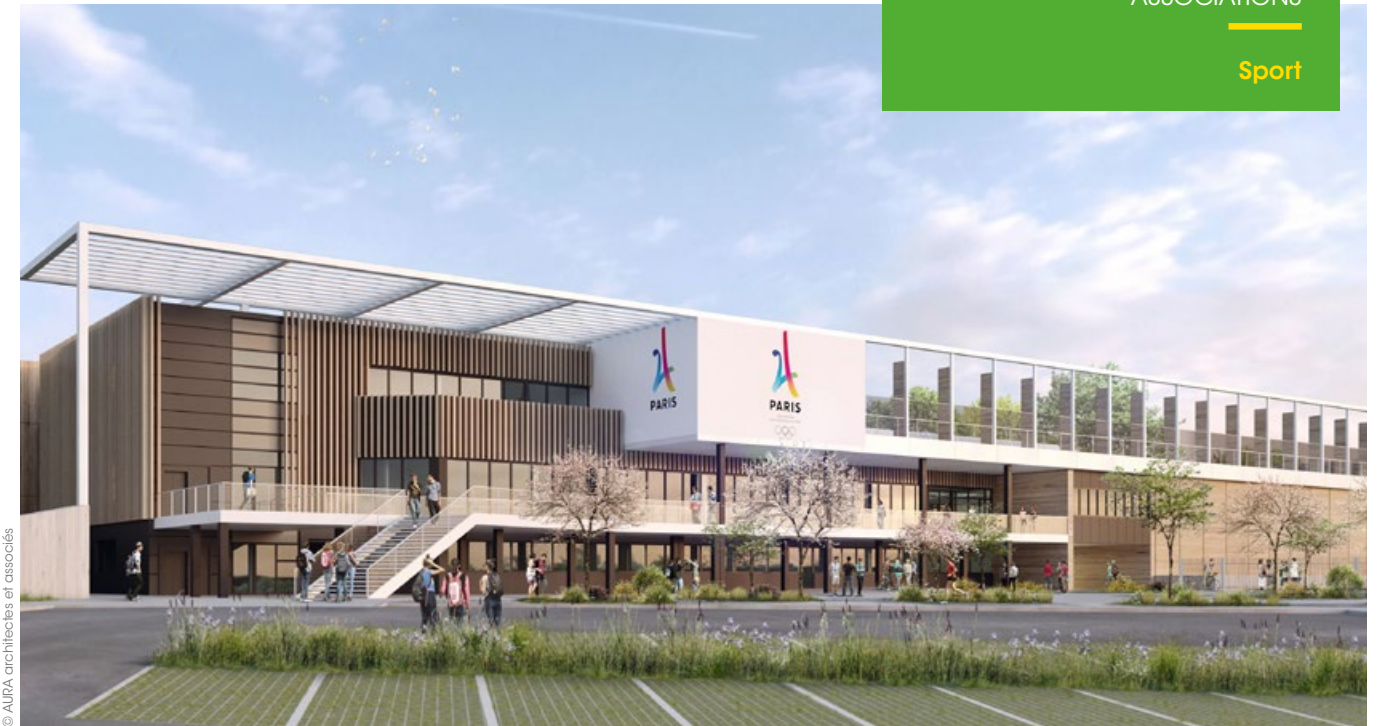
Les travaux du futur Creps des Pays de la Loire ont démarré en juin 2019. Ouverture prévue en 2021.
