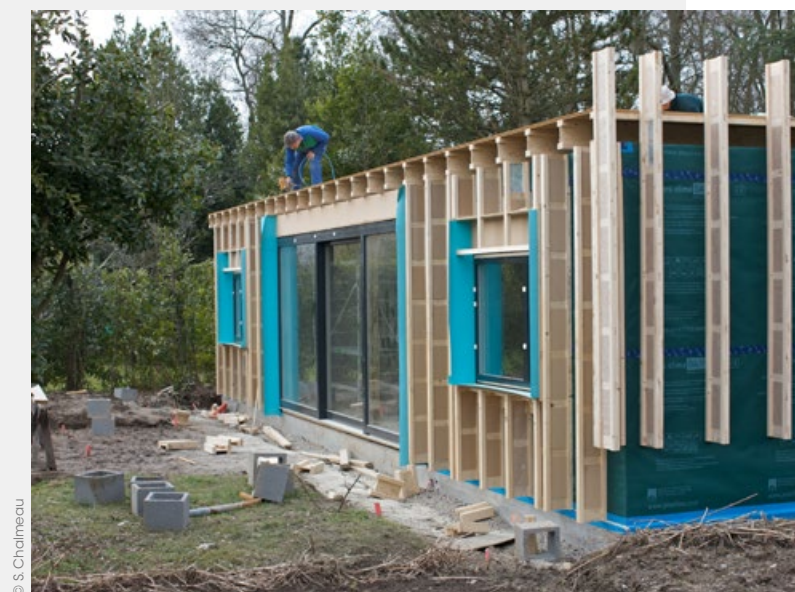
Maison à ossature bois à basse consommation d'énergie.
