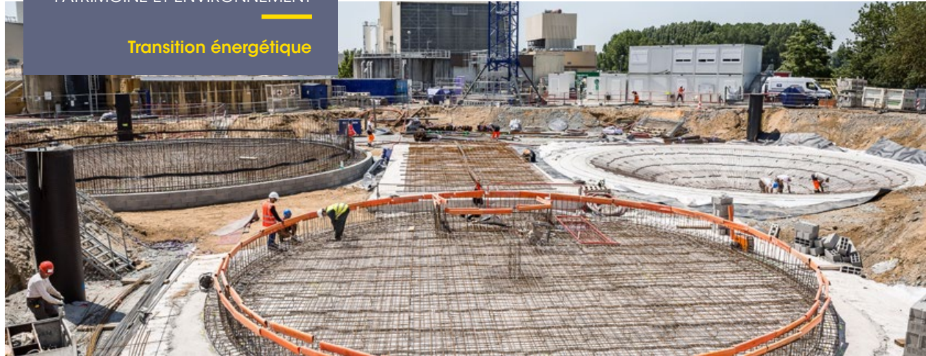
Construction d'une unité de méthanisation sur la station d'épuration de La Chauvinière, près du Mans.
